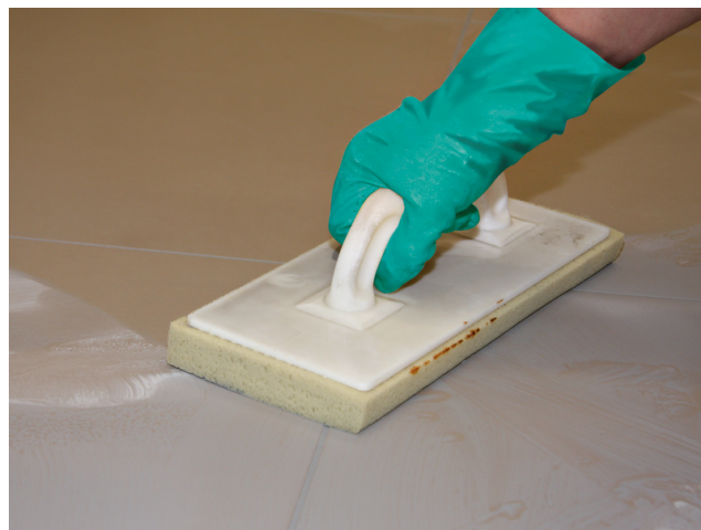
Afwassen van de tegelafwerking na voldoende standtijd van de ingevoegde Sopro voegmassa.
