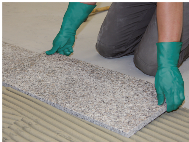
Natuursteenplaten inleggen en rechtzetten. Voegennet voor de uitharding uitkrabben.
