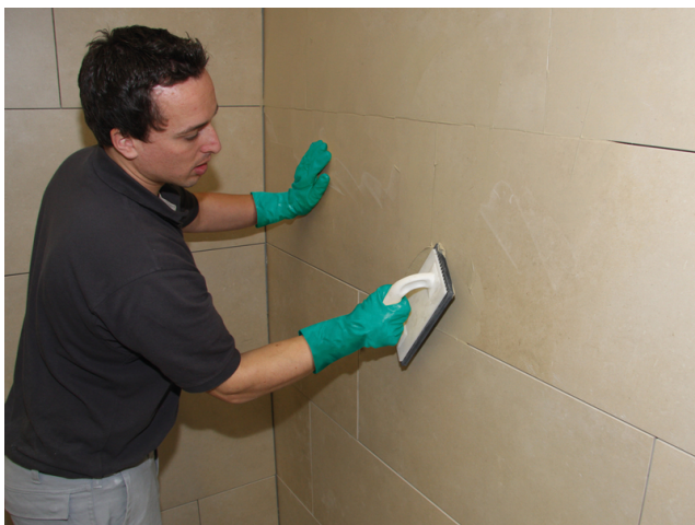
Vervoeging van het oppervlak met een Sopro Voegmassa (bijv. Sopro DF 10 DesignVoeg Flex, Sopro Brilliant ParelVoeg).
