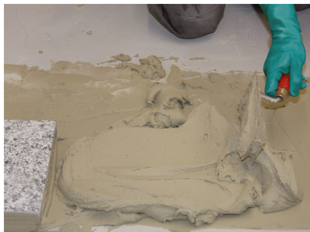
Sopro FKM XL is voor hogere mortellaagdicken tot 10 mm ook met een spaan verwerkbaar.
