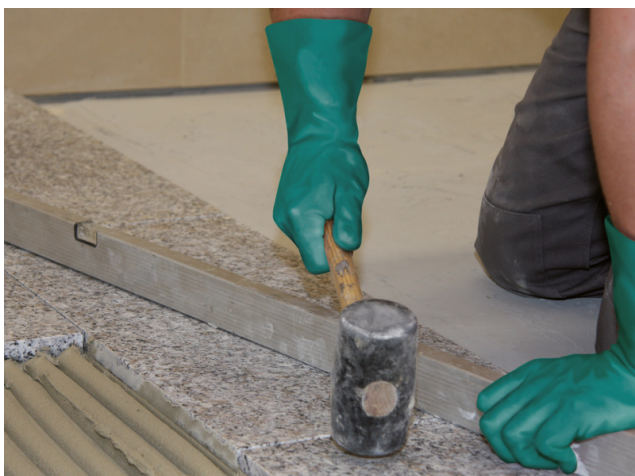
Aankloppen van de natuursteenplaten en het testen van de vlakheid.
