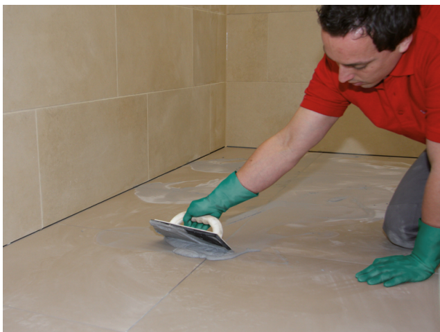
Vervoeving van het oppervlak met een Sopro voegmassa (bijv. Sopro DF 10 DesignVoeg Flex, Sopro Brilliant PareVoeg).
