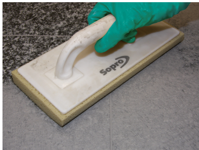
Afwassen van de natuursteenafwerking na voldoende standtijd van de ingevoegde Sopro voegmassa.
