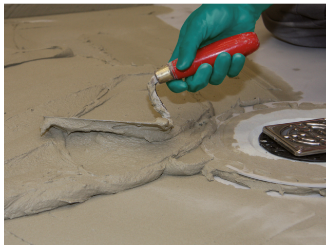
Daarna Sopro FKM XL in smeerbare consistentie op de ondergrond aanbrengen...
