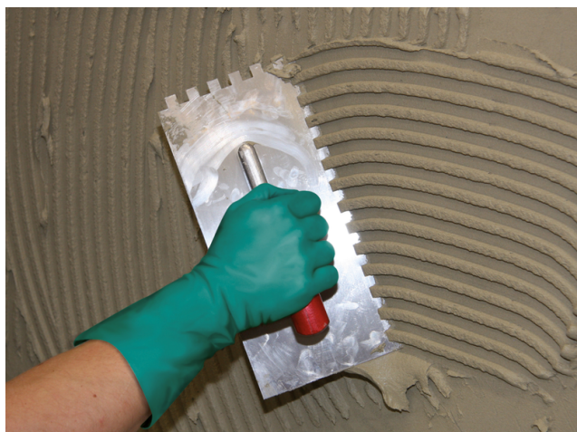
Het aanbrengen van het lijmbed in wandconsistentie op de voorbereide contactlaag.
