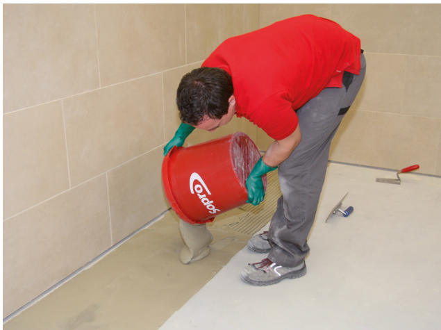
Uitgieten van FKM XL in vloiebedconsistentie op de voorbereide ondergrond.
