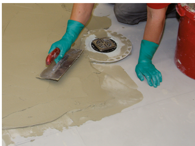
... en het afschot tot een dikte van 10 mm voorbereiden voor de navolgende systeemafdichting.
