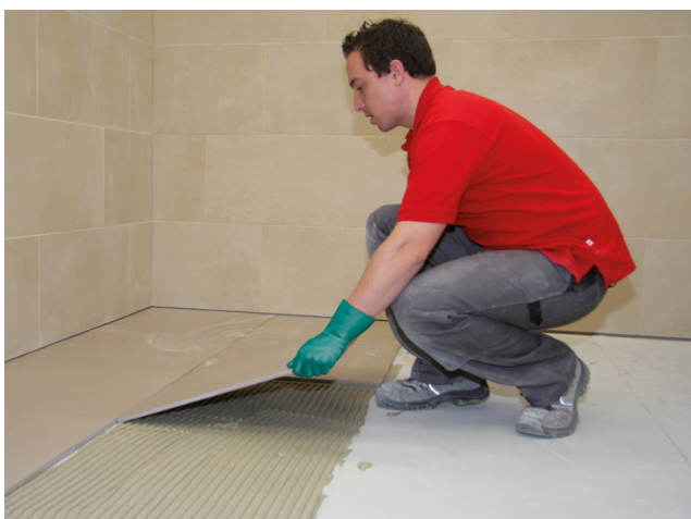
Grootformaat fijnsteengoed inleggen en rechtzetten. Voegennet voor het uitharden uitkrabben.
