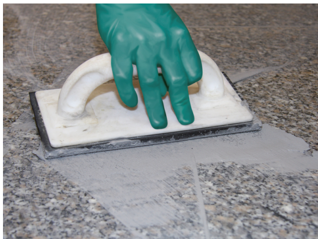
Vervoeging van de gelegde natuursteenafwerking met een Sopro voegmassa (bijv. Sopro DF 10 DesignVoeg Flex, Sopro Brillant ParelVoeg).
