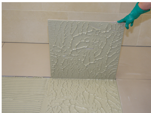
Optimale, bijna luchtbelvrije verlegging met Sopro FKM XL mogelijk.
