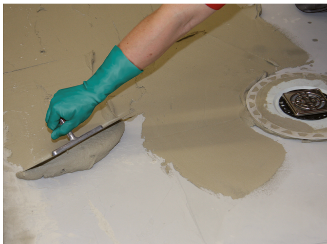
Voor het aanbrengen van een gedeeltelijk afschotnivelleer dient eerst een contactlaag met Sopro FKM XL aangebracht te worden.
