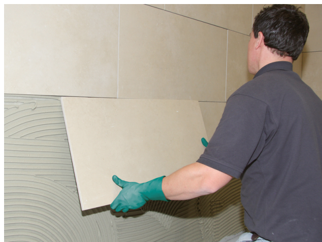
Grootformaat fijnsteengoed leggen en recht zetten. Voegennet voor het uitharden uitkrabben.
