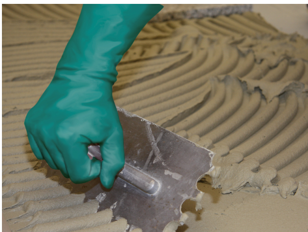
Afrijen van Sopro FKM XL in middelbedconsistentie met een middelbedspaan op de voorbereide contactlaag.
