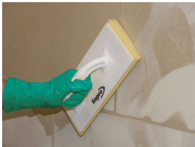
Afwassen van de tegelafwerking na voldoende standtijd van de gevoegde Sopro voegmassa.
